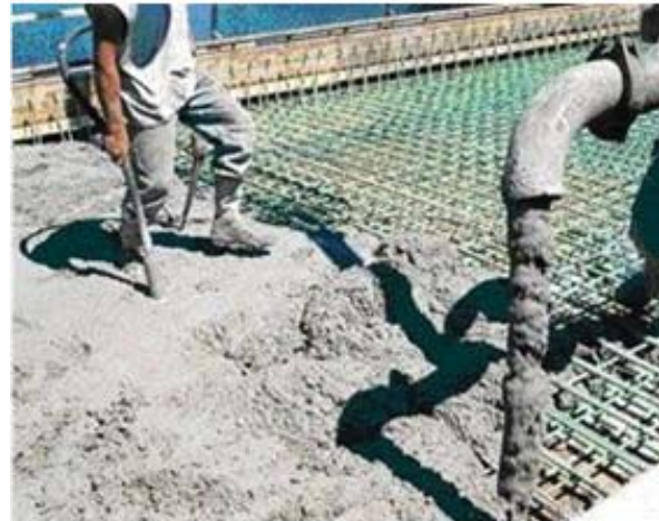
चित्र 1.3.8 वाइब्रेटर के उपयोग से कंक्रीट दबाना
