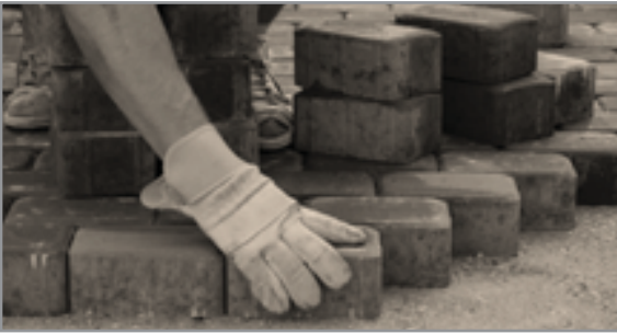
Fig. 1.2.5. Lay paver blocks
